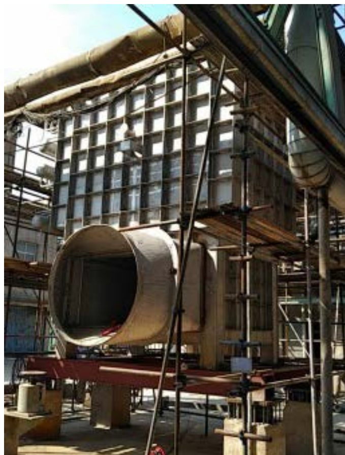
改造采用下箱体 施工过程中
