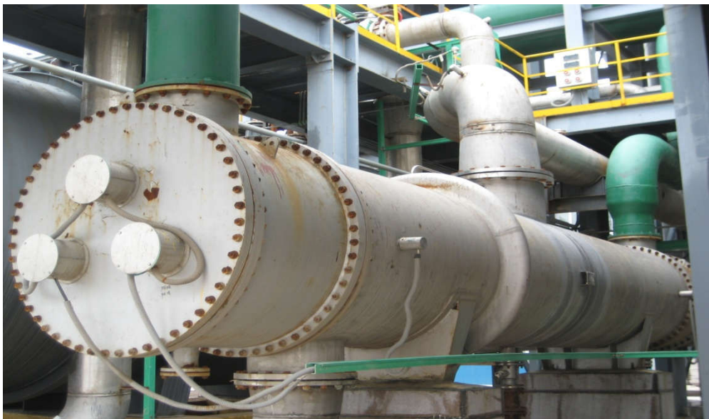
图 7 阳极保护 CMS 合金酸冷器应用现场
